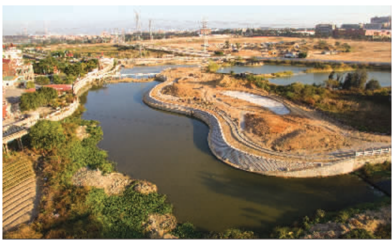
村庄、溪流、木栈道、波浪形护坡……10月25日,当记者从高空取景,在建的厝上溪厝前生态公园完整地展现在镜头面前。作为厝上溪流域(含支流)环境综合治理工程的内容之一,位于厝前村段的生态公园已初现雏形,各功能区块已十分清晰。据施工方介绍,该生态公园有望于年底前建成。(记者林恩炳 颜华杰)
