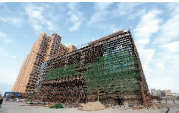
位于仓后安置楼旁的市行政服务中心正在进行二次装修工程。新行政服务中心建筑面积约32819平方米,其中地上面积23512平方米、地下面积9307平方米,预计春节后可交付使用。(记者 颜华杰)
