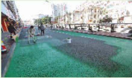
长宁路段路面在完成沥青铺设后,于近日开始铺上绿色沥青面层,全长约800米。彩色沥青面层具有防滑、耐磨、抗压等特性,相当于给原有沥青表面增加了一层“保护罩”。(记者 林恩炳 颜华杰)
