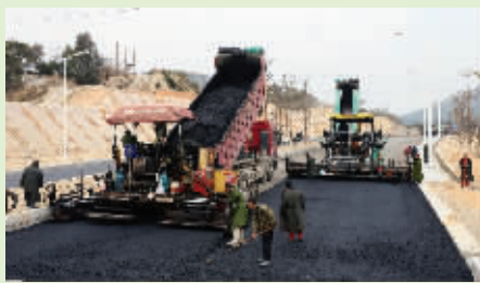
随着所有路段底层和上层沥青全部摊铺到位,峡谷旅游路主路面实现全线贯通。(记者 康清辉 颜华杰)
