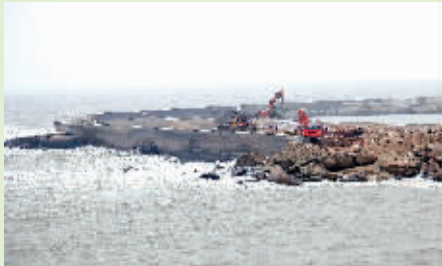
近日,位于鸿山镇伍堡村的伍堡陆岛交通码头工程建设已基本完成,只剩余面层还未施工。该工程造价约3332万元,为建设1000吨级的陆岛交通码头一座,码头泊位长105米,宽19.31米。(记者 张军璞 颜华杰)
