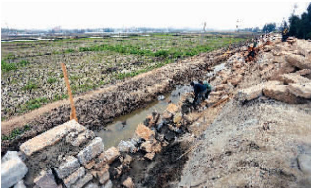
石狮环湾湿地公园开工建设了!公园位于我市环湾桥头片区。根据规划,公园一期工程将在2018年完工。(记者 康清辉 颜华杰)
