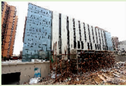
连日来,新行政服务中心室内外装修工程不断加快进度,赶在春节前外墙装修全部拆架,立面外观揭开面纱。(记者 吴汉松 颜华杰)
