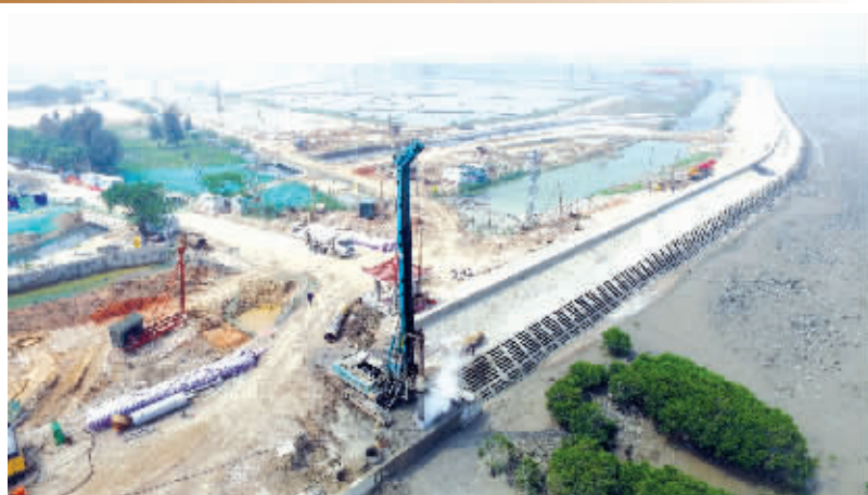
4月8日,记者选择在锦江外线主线和连接线的交叉处进行航拍,在近处的滩涂、远处的大海的衬托下,让人对这条临海而建的锦江外线充满期待。根据工期安排,到年底基本完成连接线和主线路路基施工后,市民即可较为直观地体会建设锦江外线的意义和它的魅力所在。(记者康清辉 颜华杰)
