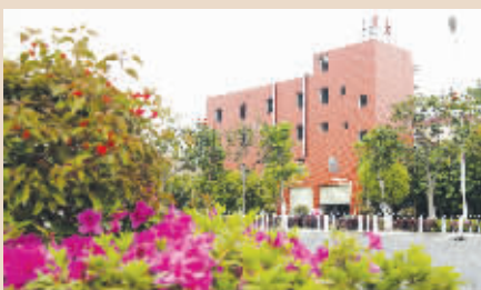
经过三个多月时间,福辉路、石狮大道两条重要通道宝盖段的“裸房”立面改造快速推进。截至3月31日,已有19栋“裸房”完成立面改造,穿上了漂亮的“新衣”。(记者林智杰 颜华杰)
