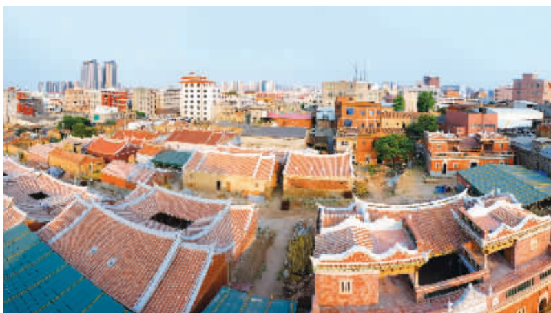
记者日前在华山古民居二期修缮保护工程施工现场看到,屋外的脚手架已经拆除,早前还是残垣断壁的建筑,已经重新筑起了石头墙,门两侧的墙上也重新补齐了雕花,整个古民居焕然一新却不失原有韵味。据悉,修缮工程已基本完工,正在加紧进行最后的收尾工程。(记者 王文豪 李荣鑫)
