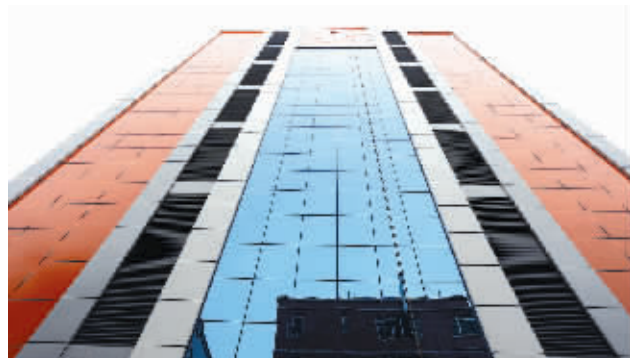
位于市妇幼保健医院的“长福”智能立体停车场目前已进入最后的设备调试及室外工程收尾阶段。根据计划,将在6月下旬建成交付使用,总共能提供208个停车位。(记者 康清辉 颜华杰)
