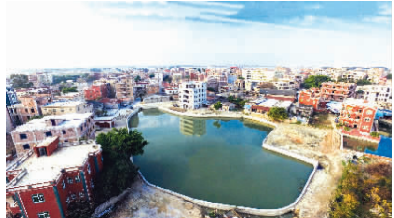
连日来,位于蚶江镇莲中村的东田塘整治工程施工现场,专业施工人员正抓紧项目收尾施工。作为石狮水系环境综合治理项目之一,莲中村负责人表示,小流域综合整治工程造福于民,都官溪整治工程二标段东田塘改造项目,加快了莲中村“美丽乡村”建设步伐,为村民群众谋福利。 (记者 兰良增 李荣鑫)
