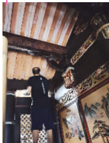
修复室内装修
