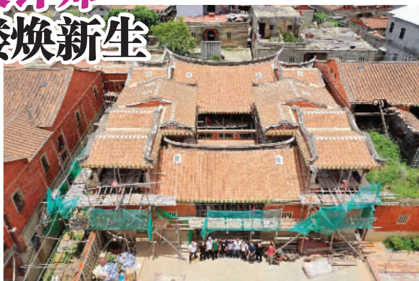
古厝修缮即将完工
