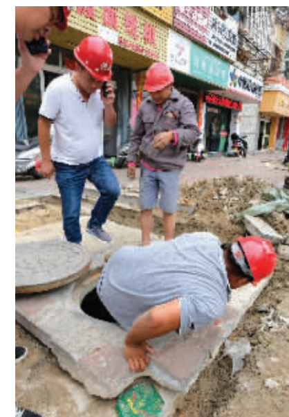
供水管道抢修工人
