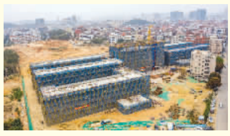
近日，石狮鹏山学校(一期)中小学部7栋功能楼实现全部封顶。根据工期安排，小学部计划5月份开始落架，中学部计划8月份开始落架。(记者 康清辉 颜华杰)
