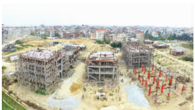
福厦客专(蚶江段)水头村段沿线两侧的安置区建设进入大面积建设阶段。截至目前，规划建设的25幢安置楼已有16幢正在建设中。(记者 兰良增 李荣鑫)
