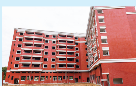
近日,记者在宝盖镇苏厝村采访时看到,该村文化活动中心又有新变化,大楼的外墙装修已全部完工,这意味着该项目建设已接近尾声。 (记者 林智杰 颜华杰)
