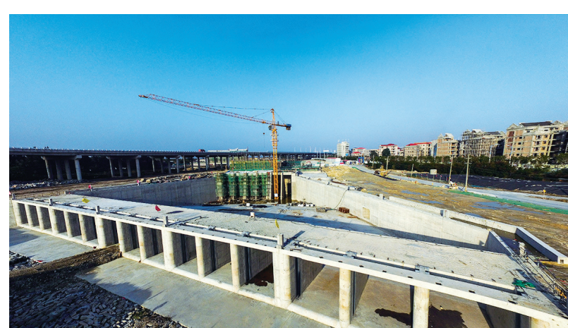
近日,记者在福建省级重点项目——石狮水头排涝枢纽工程施工现场看到一片繁忙景象:工程自2月10日有序恢复节后生产以来,施工人员在闸6—7#孔检修门槽预制板、上下游消力池及1—5#孔上部启闭房装修、泵站管理房桩基检测等各道工序上,整体工程已初具雏形。该工程预计于今年12月底全部完工并投入使用。 (记者 兰良增 李荣鑫)
