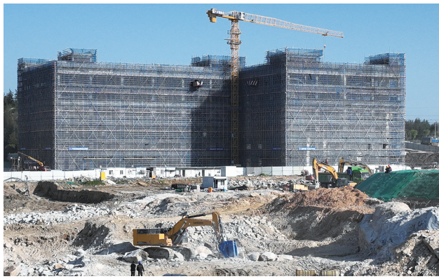
福建省重点项目石狮光子产业园一园建设进展顺利,该园区一期工程11#、10#两栋中型厂房内外装修施工扎实推进。该项目预计明年可完工。(记者 尼松义 李荣鑫)
