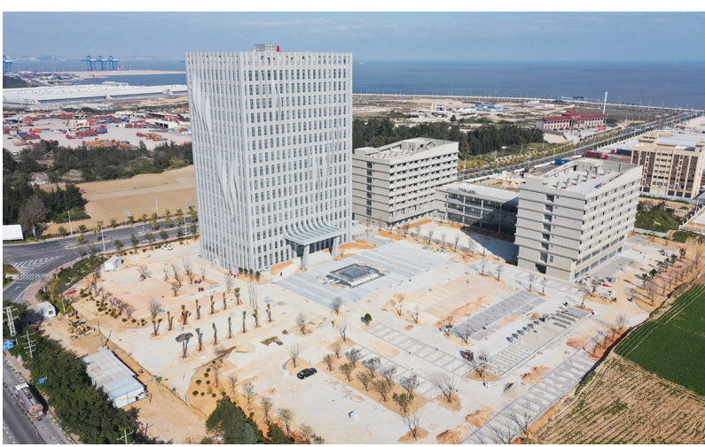
作为石狮2023年抓城建提品质“城市功能补短板”类项目之一,位于港口大道与沿海大通道交叉口的泉州港石狮航运中心,其建设已经进入最后的扫尾阶段。根据工期安排,整个项目将在二季度全部完工。(记者 康清辉 颜华杰)
