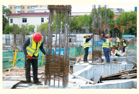
钢筋切割、绑扎……在福建技师学院石狮（蚶江）校区二期项目现场，建筑工人们忙碌的身影穿梭在工地各个角落。据介绍，该项目已完成总工程量的15%，预计5月进行主体封顶。（记者 高佩君 程高岗）
