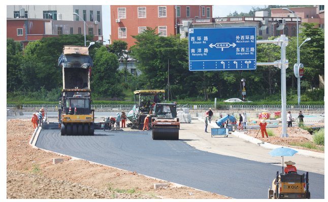
7月4日,二重环湾快速路匝道(晋江至狮城大道)项目正式开始底层沥青的摊铺。根据工期安排,该项目由石狮负责的接地工程在本月底基本可以建成。 (记者 康清辉 颜华杰)
