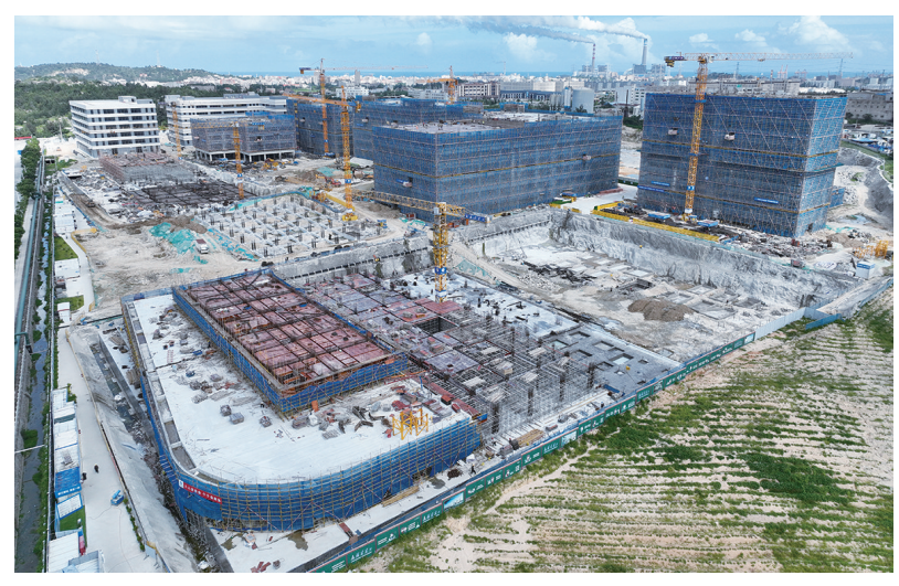
记者7月3日在石狮光子技术产业园一园二期项目工地看到,一座座标准厂房建筑拔地而起。据项目建设有关负责人介绍,截至目前该园区二期工程已有14栋标准厂房、研发中心和宿舍楼正在加紧建设中,多栋厂房、宿舍楼和研发中心有望近期封顶。他们将严格监督,保障施工质量,确保该项目于明年顺利完工。 (记者 尼松义 李荣鑫)
