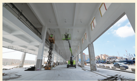
祥芝中心渔港两栋卸鱼廊道施工进入尾声。据悉,项目计划在7月份建成,以便8月中旬开渔后可及时投用。 (记者 康清辉 颜华杰)
