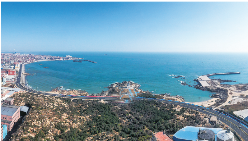
2024年伊始,石狮海岸带提升,再一次漂亮“交卷”。1月13日,记者从国投集团交建公司获悉,历经半年多时间攻坚,国道228线(莲坂至伍堡段)提升改造工程,主体工程已于日前完工,成为石狮又一段经典的滨海景观廊道。
