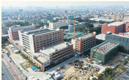
作为扩建(二期)工程,蚶江中学新建的一栋学生公寓、一栋高中教学楼正加速主体结构施工。其中,靠石狮大道边的学生公寓,预计本月底将率先实现主体封顶。
