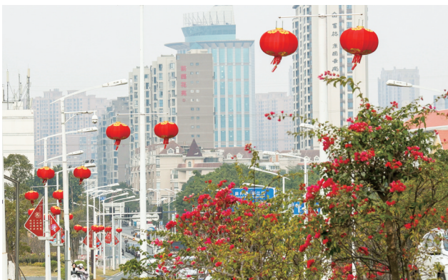
1月19日,记者在峡谷旅游公路学府公园段看到,工作人员正在安装大红灯笼。挂上大红灯笼的公路,年味渐浓。据悉,我市几条市区主干道将陆续安装大红灯笼。(记者 颜华杰)
