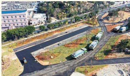
沿海大通道伍堡土地公宫段,路外原来的杂乱地块,通过重新整理,正打造为一处兼具停车功能的口袋公园。
