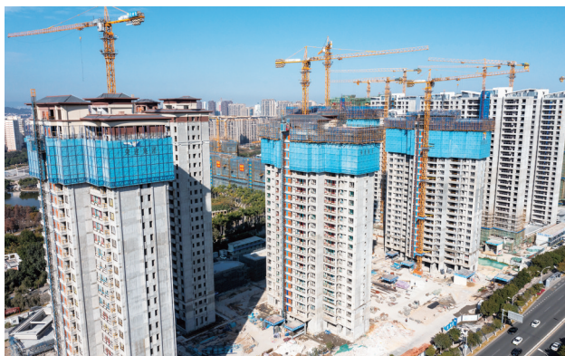
1月13日,随着最后两栋楼完成顶层楼板浇筑,龟湖公园东片区安置房项目5栋高层住宅全部封顶。整个项目计划在2024年12月完成外立面装修。
