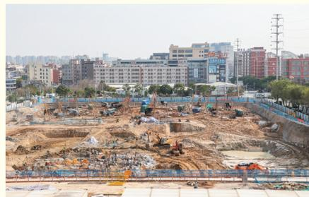
位于灵秀镇西灵路中段的灵山“电商人才社区”，目前正交叉推进桩基施工和地下室的土方开挖。今后，这里将崛起9栋12层的建筑，打造为可容纳近400户居民的现代化小区。（记者 康清辉 颜华杰）
