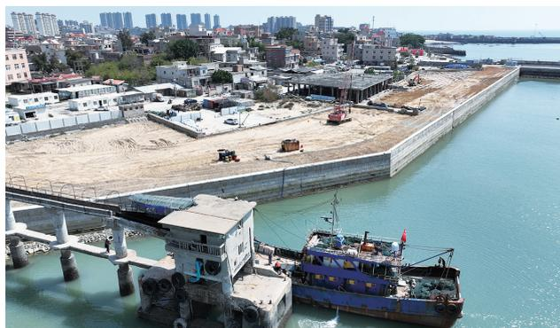
石狮市梅林一级渔港护岸及陆域形成工程日前完成陆域沙、石料回填以及混凝土浇筑等工序。至此，该工程顺利竣工，并将于上半年进行整体初步验收。（记者 洪亚男 李荣鑫）
