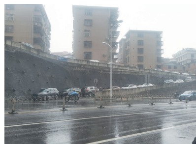
位于下泽角落的一小段馆顶路沟现状
