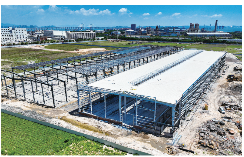
蚶江智能制造园建设加速。目前,该园区新增的华玉衡科、极利新材料、中科创谷3个项目已开工,预计到2025年该园区产值可达100亿元以上。图为正在抢抓建设进度的极利新材料公司无纺布、热熔胶港宝、水性定岛超细纤维绒布生产项目。(记者周进文 李荣鑫)
