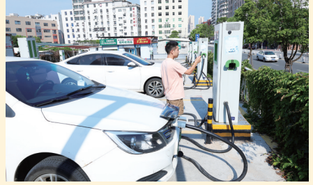
湖滨街道花园城社区公共充电站近日投入使用。站内配备快充桩23个和液冷超充桩1个,同时还配备暖心驿站,供来往车主休息。(记者黄翠林 郭雅霞)
