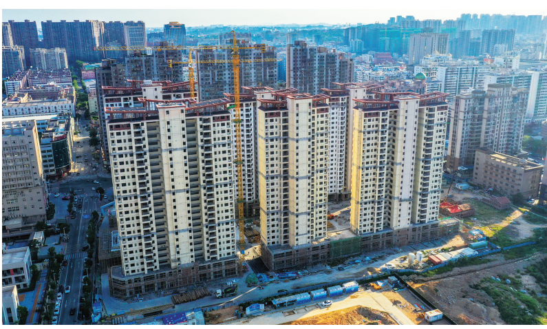
继6栋高层住宅建筑全部封顶之后,宝盖镇前园片区安置房项目内外装修工作加快推进。日前,记者在该片区采访时看到,6栋安置房的外架已拆除,室外工程也在同步进行中。小区主要建设6栋22—24层的高层住宅、2栋附属配套用房,建成后可新增468套住宅。前园片区安置房项目施工方有关负责人介绍,预计今年12月可进行工程初验。 (记者 林智杰 颜华杰)
